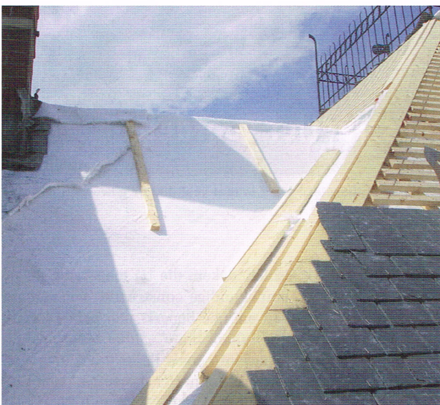
Spaceloft is een flexibele, nanoporeuze aerogel isolatiedeken die in allerlei bouwkundige constructies een uitstekende thermische isolatie kan verzorgen.
