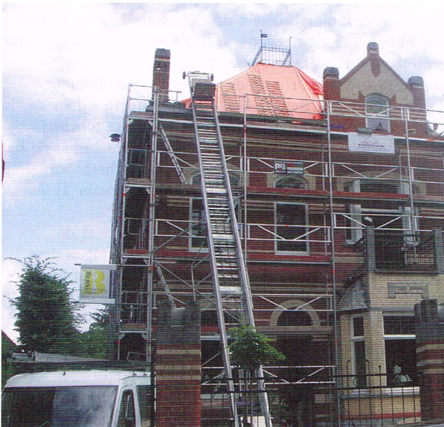
Het statige herenhuis in Weert waar het leidendak is vernieuwd en geïsoleerd met Spaceloft deken.
