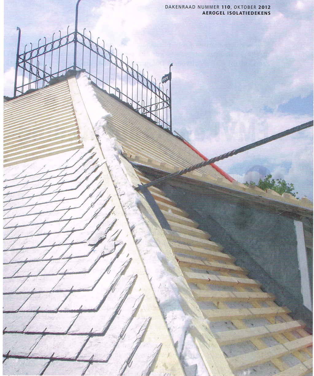
Ook de loketten langs de wangen van de dakkapellen en schoorstenen konden op hun plaats blijven.
