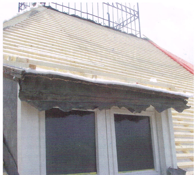
De dikte van de isolatiedeken kan 5 mm of 10 mm zijn; een ideale dikte voor renovatiewerk.
