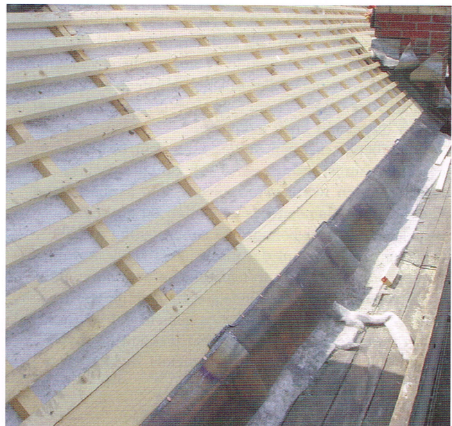
Door de geringe dikte hoefde de leidekker de gootconstructie in Weert niet aan te passen.
